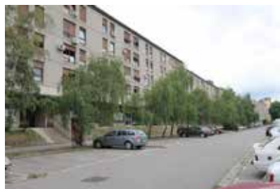
Zagreb, Špansko , 47m 2 , 3 sobe, lift, useljivo, 55.000 € , (418.000 kn), ID: 601zgst
