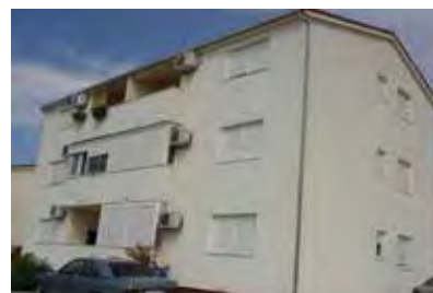
Kaštela, Kaštel Stari , 55m 2 , 2 sobe, loggia, prizemlje, parking, useljivo, 2005 god., EC: B, 85.000 € , (646.000 kn), ID: 272kast
