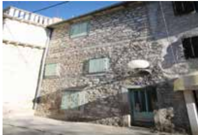
Kaštela, Kaštel Lukšić , 90m 2 , 4 sobe, 4 etaže, potrebno uređenje, 68.000 € (516.800 kn)
