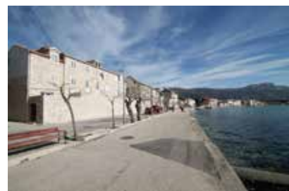
Kaštel, Kaštel Novi
